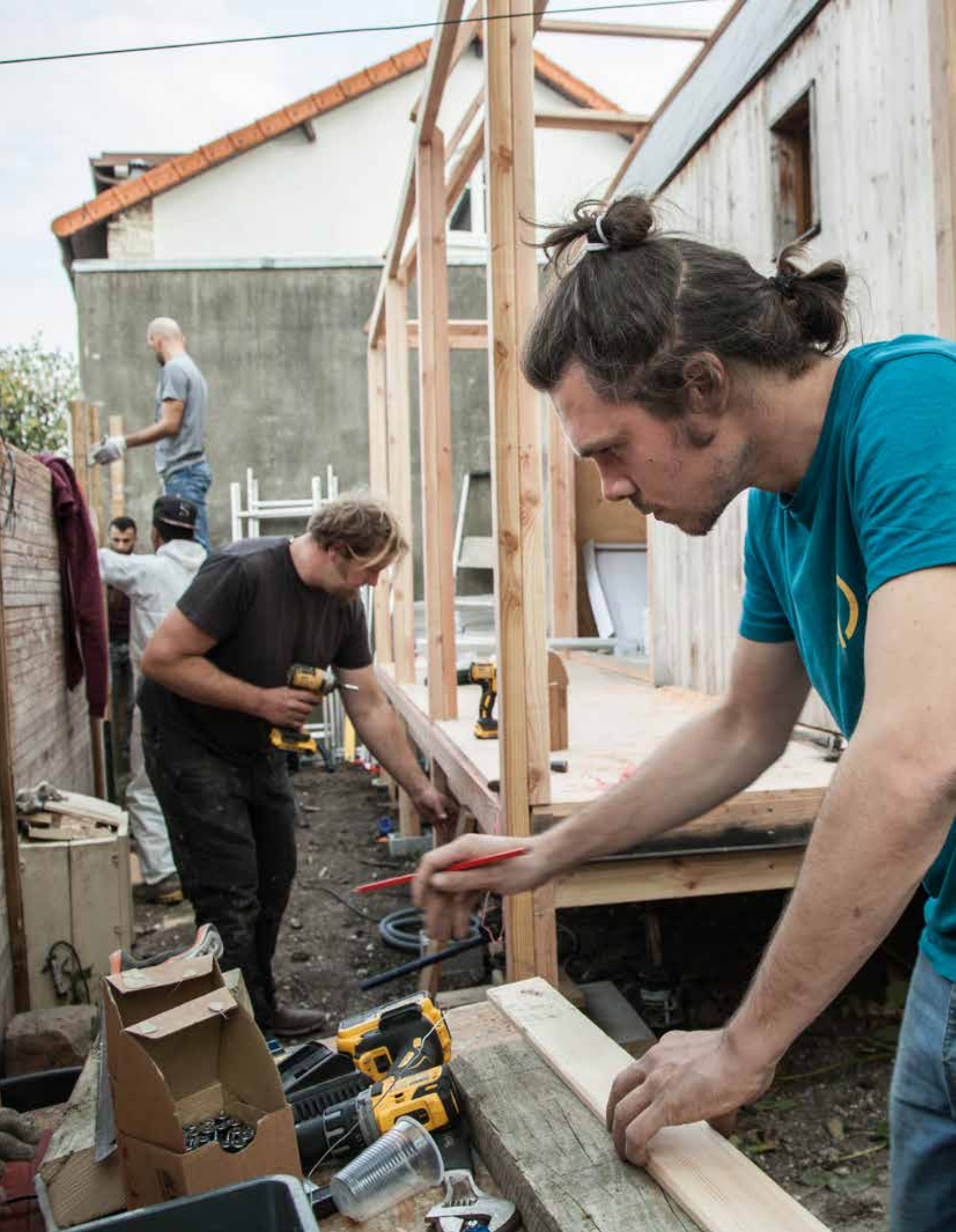
Photo du chantier international participatif, Octobre 2017, Crédits : Livia Saavedra
